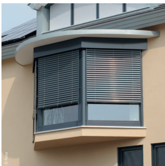
Brise-soleil rénovation, parfaitement jointifs sur l'angle extérieur
